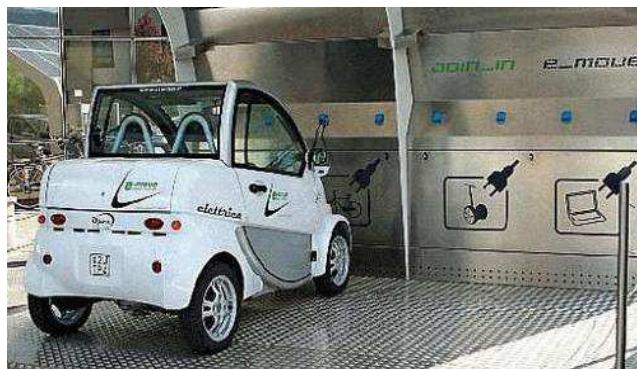
3.45. att. E-Move uzlādes stacijas pieslēguma punkts
