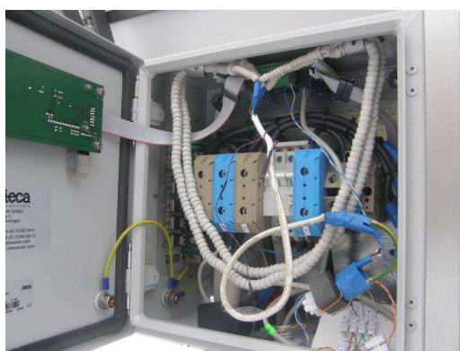
3.120. att. Keramiskā sildītāja uzstādīšana kontrolera skapī
