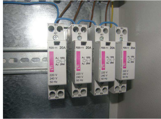
3.88. att. Kontaktoru izvietojums
