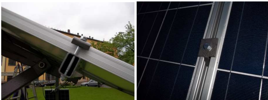
3.56. att. Fotoelektrisko moduļu stiprinājumi
