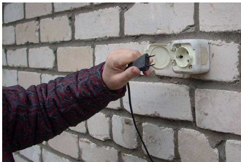
2.5. att. Uzlādes rozete ar vāciņu uz garāžas ārsienas
