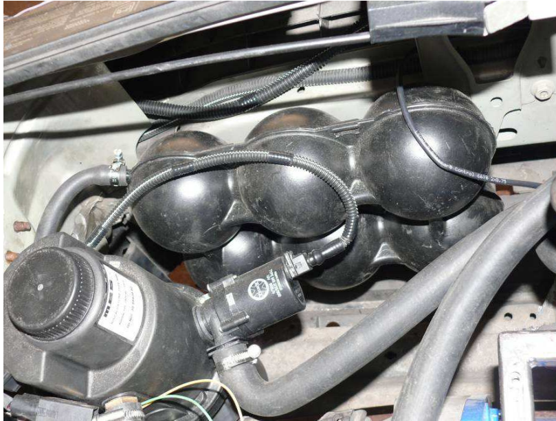
4.83. att. Elektriskais salona sildīšanas mezgls un bremžu vakuuma pastiprinātāja resīvers
