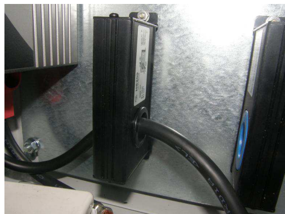
3.90. att. Uzlādes kontrolera sensoru izvietojums
