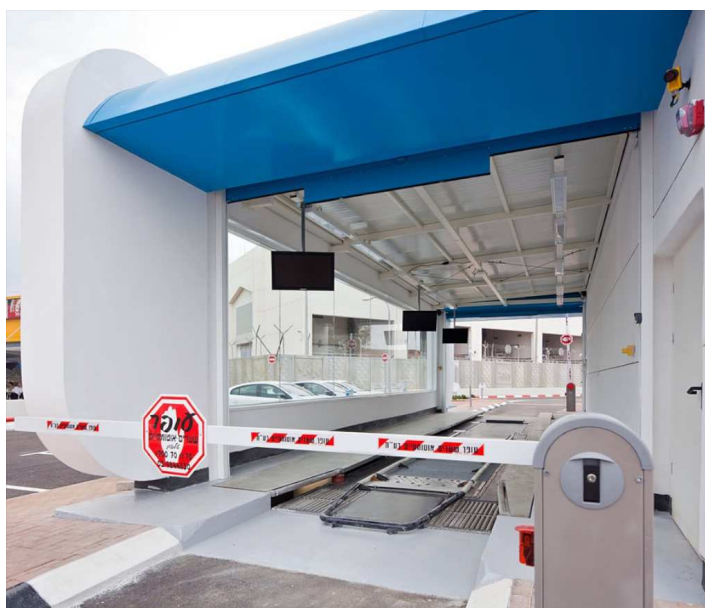
2.53. att. Bateriju apmaiņas stacijas iebrauktuve
