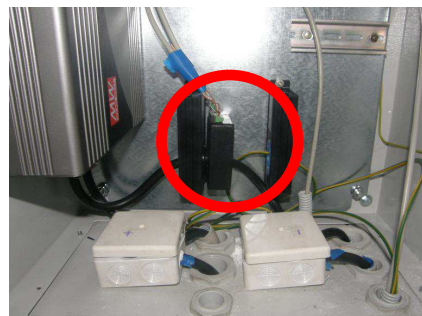
3.110. att. UIT mēritāja uzstādīšana invertora skapī S2
