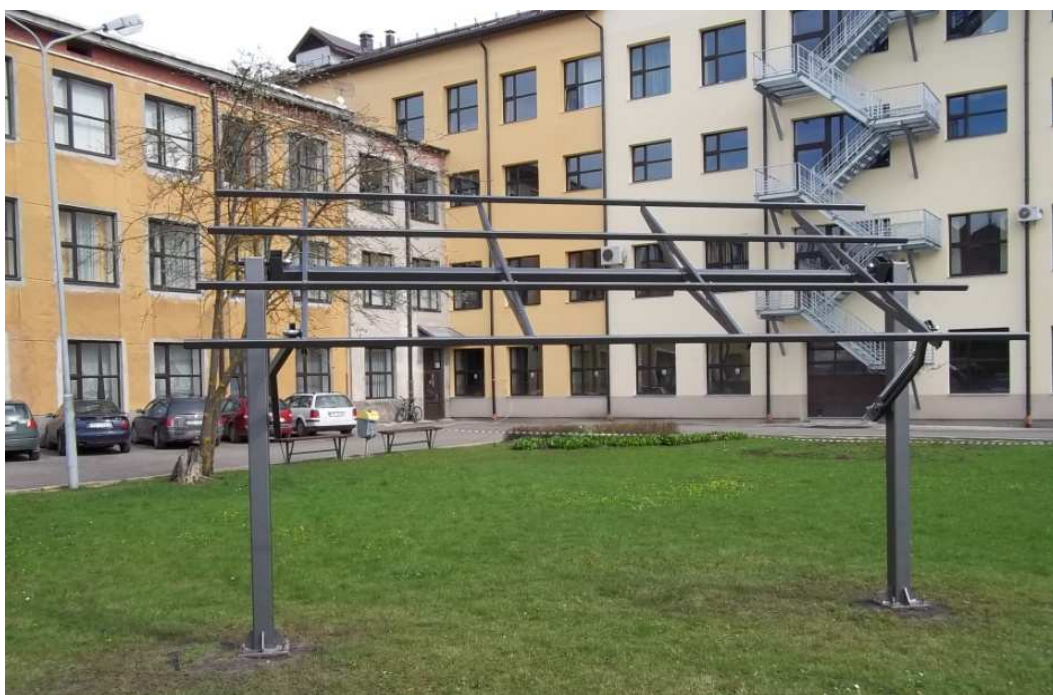
3.55. att. Alternatīvās enerģijas uzlādes stacija rāmja konstrukcija
