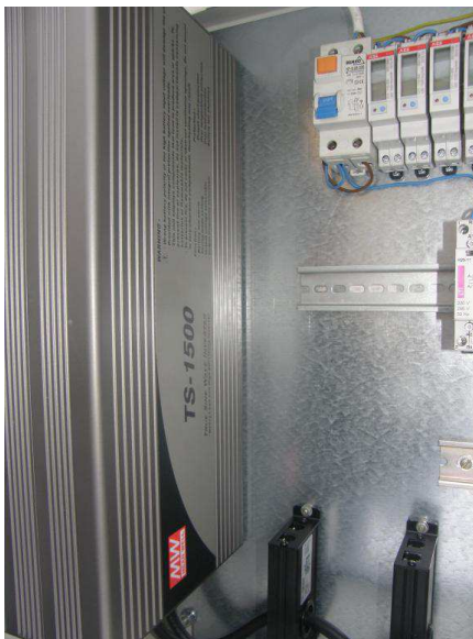
3.89. att. Invertora izvietojums
