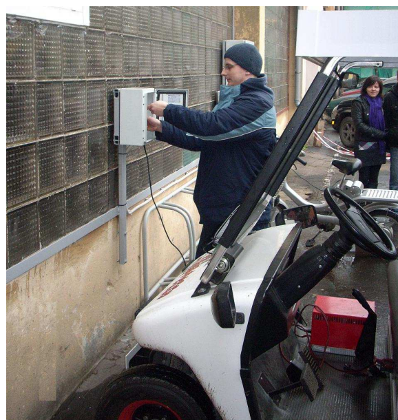
2.19. att. Lēngaitas elektromobiļa kabeļa pieslēgšana uzlādes punktam
