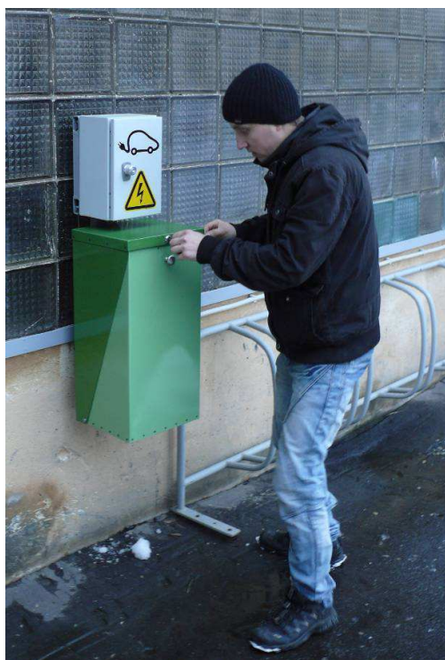
3.72. att. Uzlādes skapis, montēts elektroskāpju lādēšanas punktā
