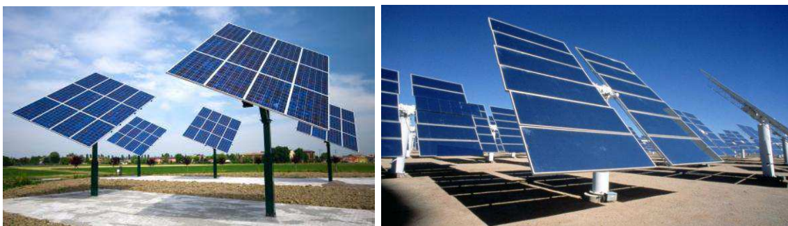
3.53. att. Solāro paneļu stiprinājumi uz vienas statnes
