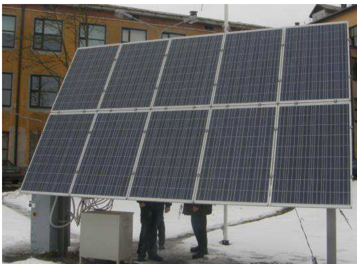
3.75. att. 2 kW fotoelektriskās baterijas
