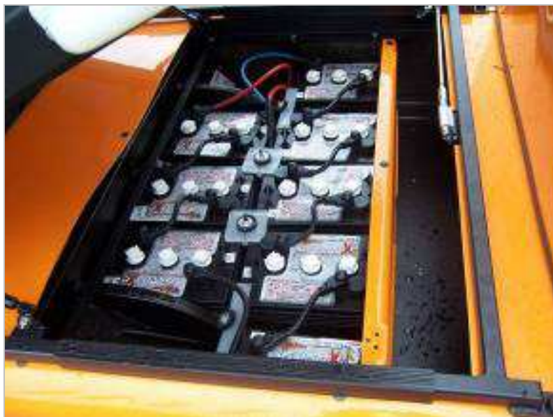
1.30. att. Akumulatoru nodalījums zem kravas kastes
