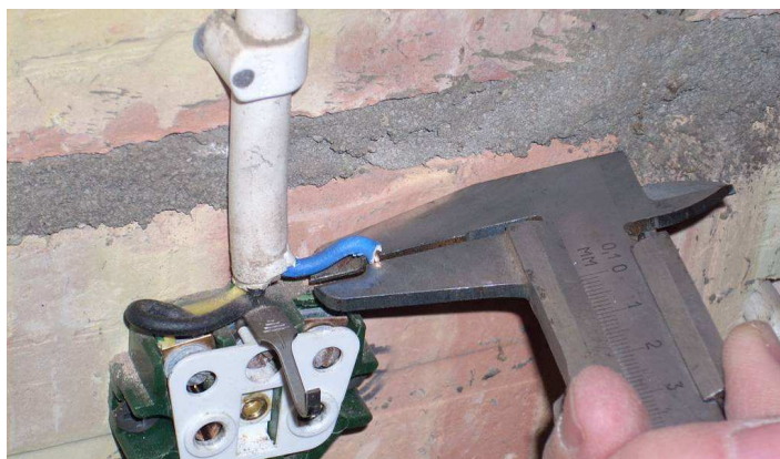
2.3. att. Uzlādei paredzētās rozetes pievada vadu diametru mērījumi
